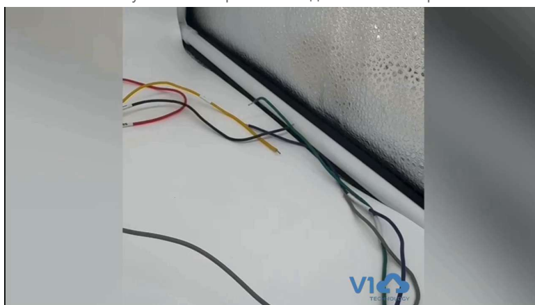
Проверка проводов перед подключением
